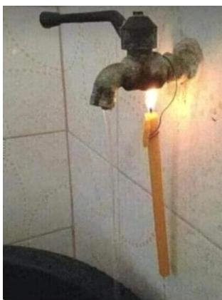
Per l’acqua calda inverno 2022...
